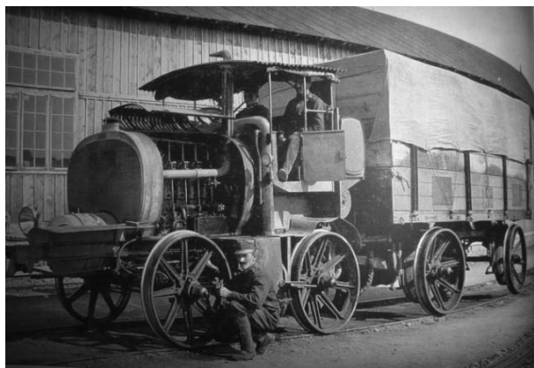
Fig. 2. „Locomotiva” unui tren benzino-electric în timpul Fig. 3. Halta Tihuța, perioada 1916-1917, situată la 20 km unei revizii în depoul Tiha Bârgăului, 1916 de Tiha Bârgăului și la 13 km de Dornișoara (foto ing. Ilie Popescu)
