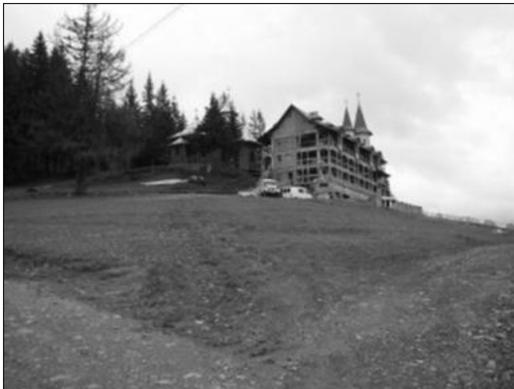
Fig. 1. Mănăstirea în construcție
